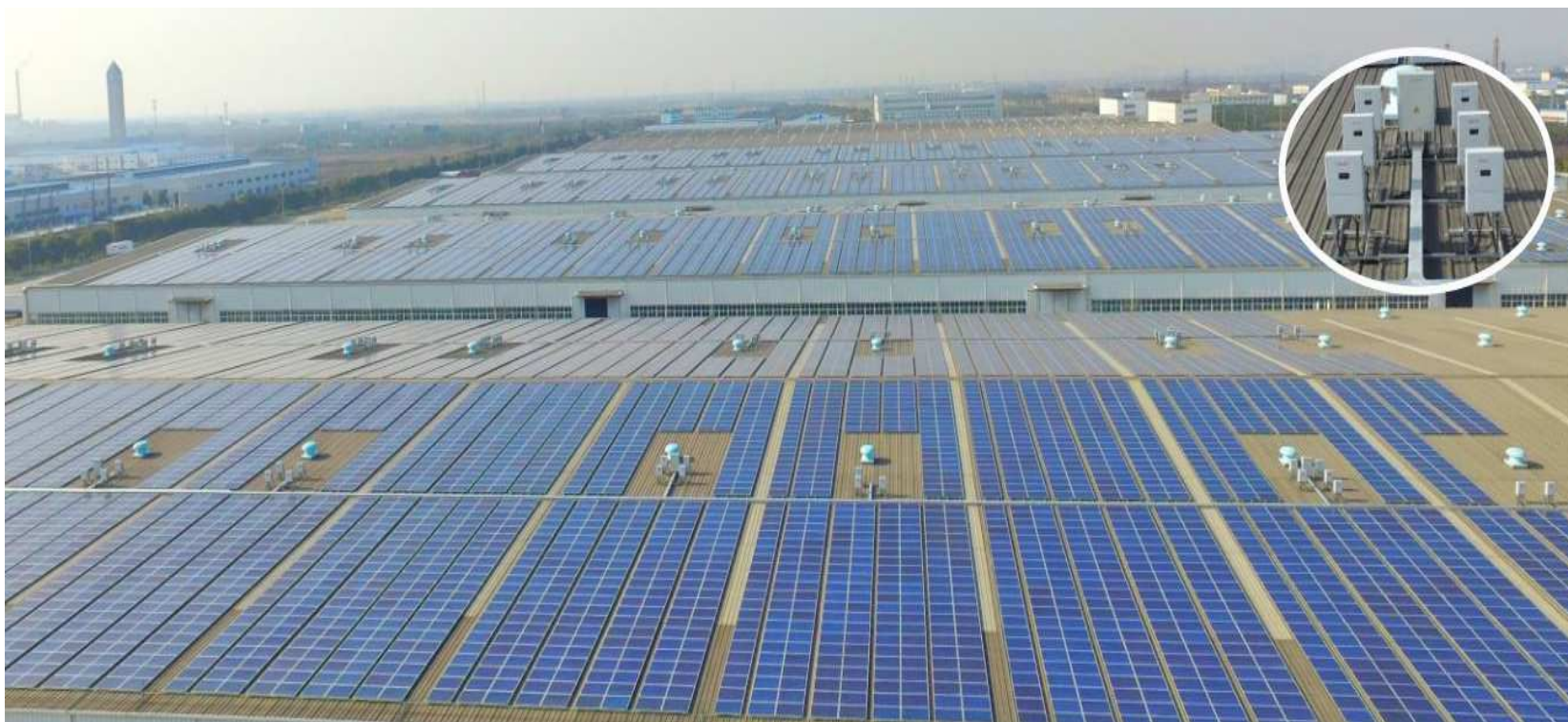
Крупнейшая в мире накрышная (rooftop-mounted) СЭС общей мощностью 300МВт (Нaining, Китай)
